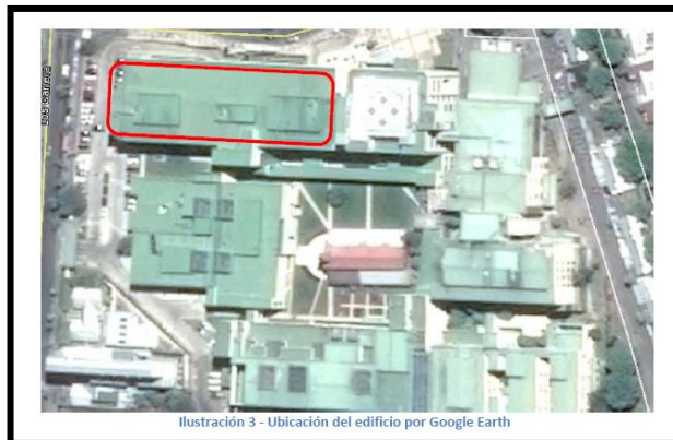
Ilustración 3 - Ubicación del edificio por Google Earth
